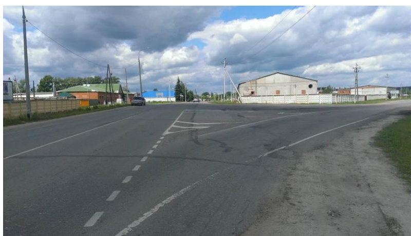
Рисунок А.8 – Фото входа 3 на перекрёсток ул. Привокзальная – ул. 8 марта
