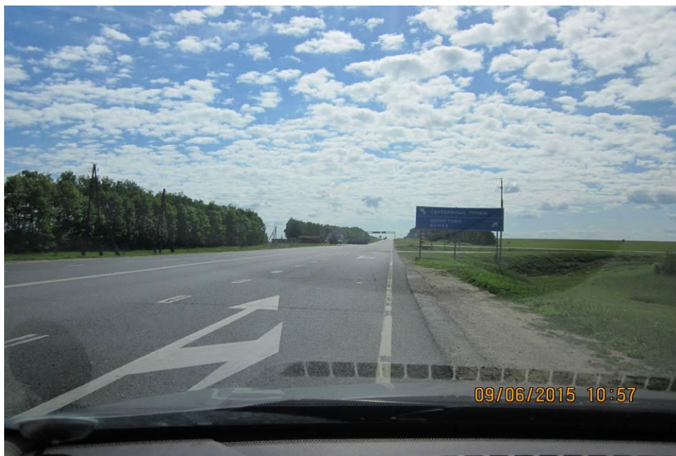
Рисунок А.33 – Фото входа 1 на перекрёсток Р-22 – Поворот на Венёв
