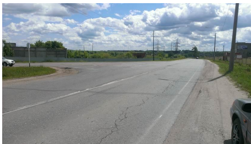
Рисунок А.6 – Фото входа 1 на перекрёсток ул. Привокзальная – ул. 8 марта
