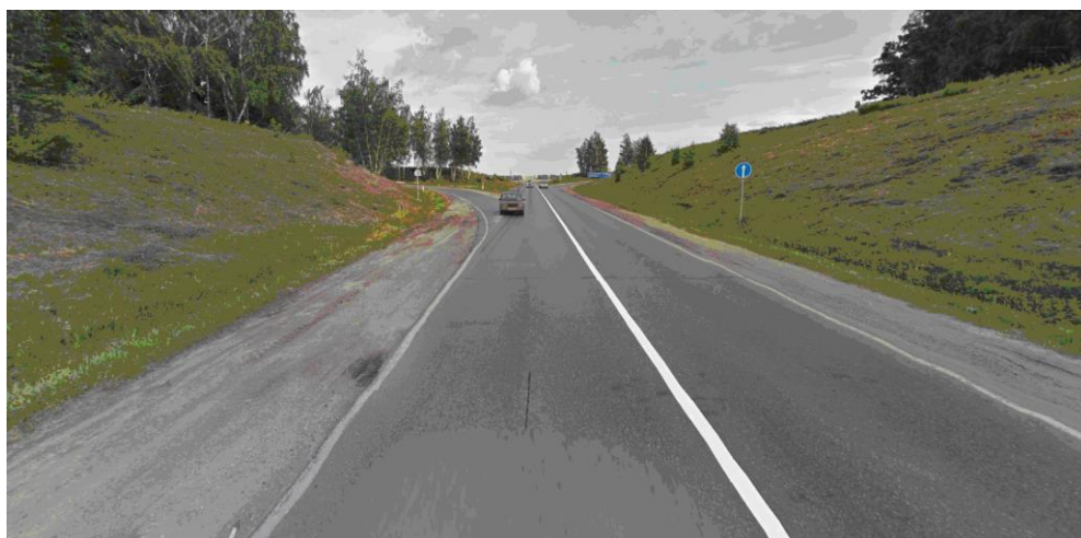
Рисунок А.28 – Фото входа 1 на перекрёсток Р-22 – Р-114
