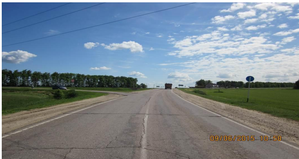
Рисунок А.36 – Фото входа 4 на перекрёсток Р-22 – Поворот на Венёв
