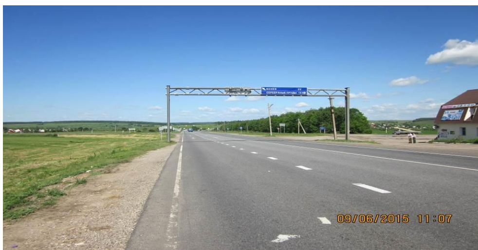
Рисунок А.35 – Фото входа 3 на перекрёсток Р-22 – Поворот на Венёв
