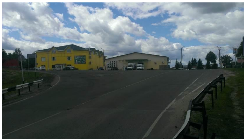
Рисунок А.10 – Фото входа 1 на перекрёсток ул. Октябрьская – ул. 8 марта
