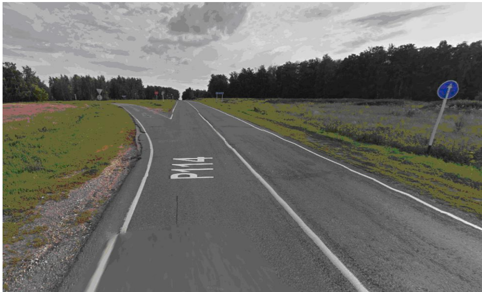
Рисунок А.29 – Фото входа 2 на перекрёсток Р-22 – Р-114
