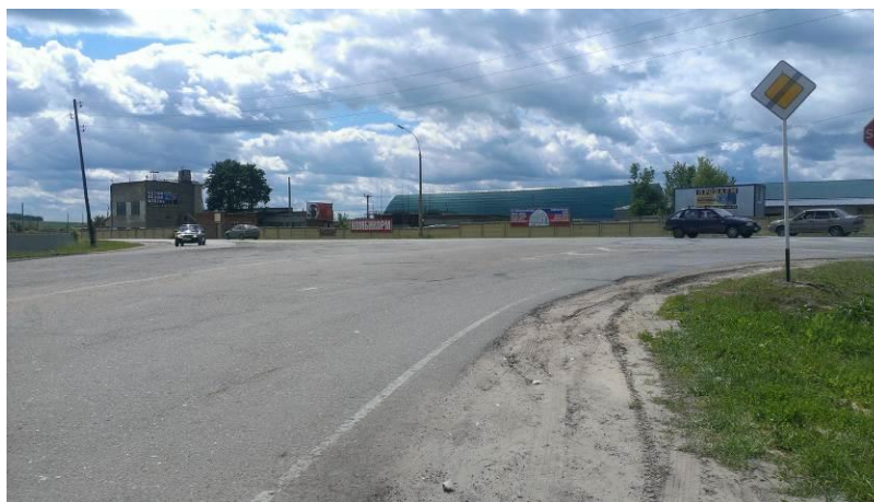
Рисунок А.7 – Фото входа 2 на перекрёсток ул. Привокзальная – ул. 8 марта
