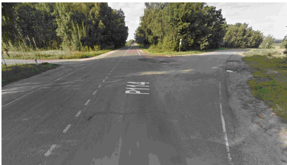
Рисунок А.31 – Фото входа 4 на перекрёсток Р-22 – Р-114
