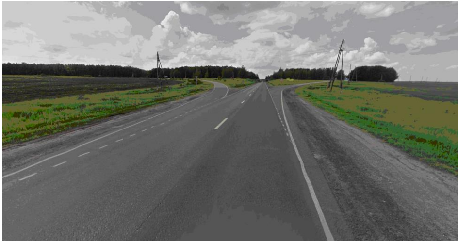
Рисунок А.30 – Фото входа 3 на перекрёсток Р-22 – Р-114
