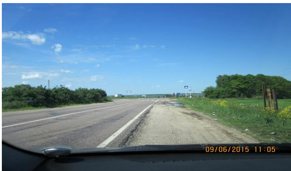
Рисунок А.34 – Фото входа 2 на перекрёсток Р-22 – Поворот на Венёв
